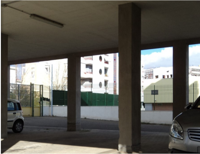
Particolare piano pilotis
