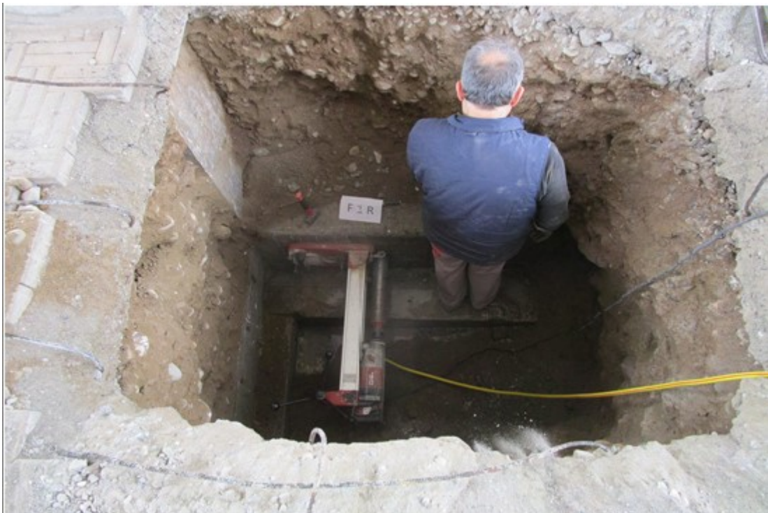
Particolare scavo eseguito al piano terra per indagare le travi di fondazione - Si noti che i pilastri sono interrati per oltre un metro prima di raggiungere l'estradosso della fondazione
