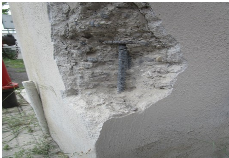
particolare prelievo barra di armatura pilastro piano terra
